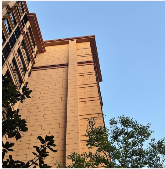
柴油发电机排气筒
