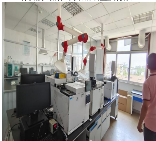
有机废气集气罩
