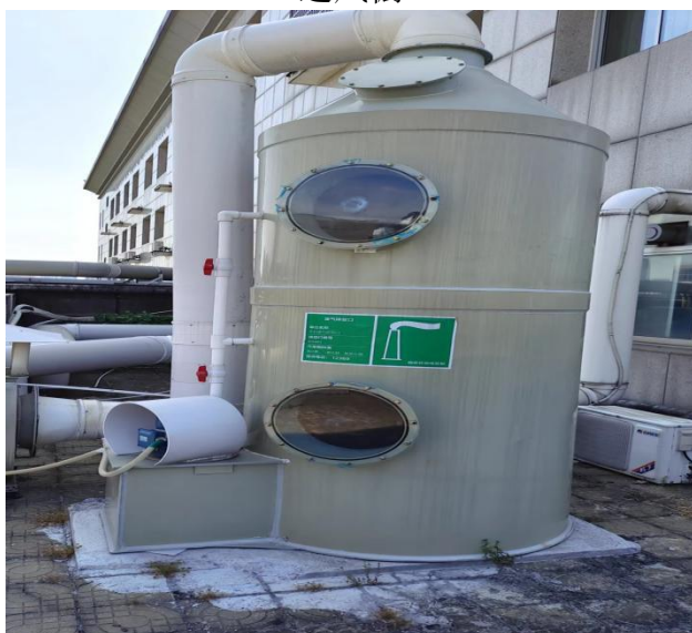
无机废气喷淋设施
