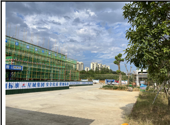
地块东侧现状
