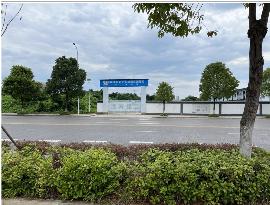
图 3.4-1 妇幼保健院生活区建设工程（东侧）
