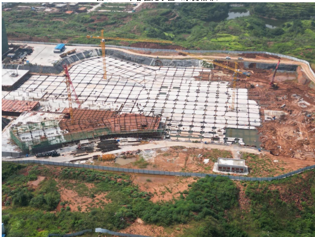
图 3.4-2 邵阳市第三人民医院（南侧相邻）
