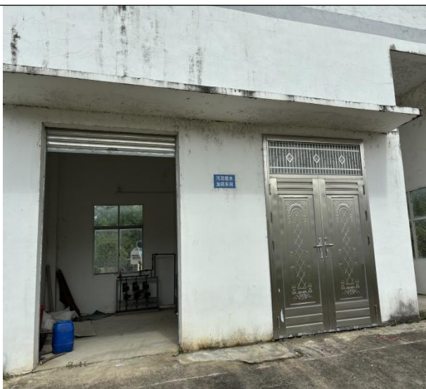
污泥脱水加药车间
